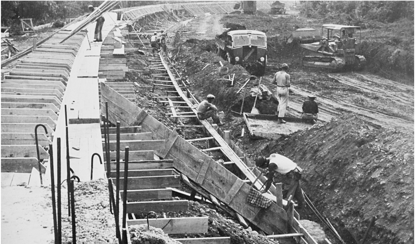
La sopraelevata durante la costruzione e, sotto, il suo restauro del 2014.
